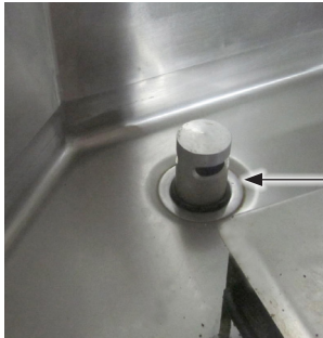
Drain Stand Pipe
